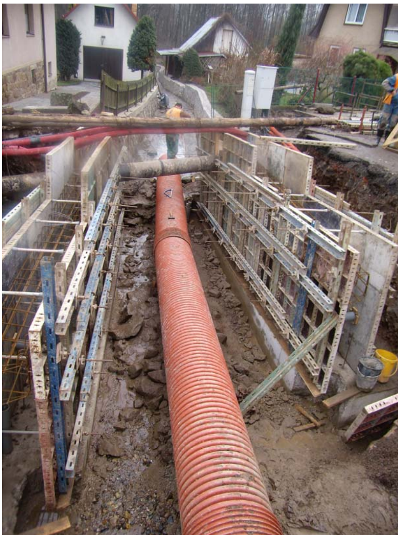
Foto č. 1: Široký potok – Hlásný profil s automatickým vyhlásování SPA v profilu silničního mostu místní komunikace v ř.km 1,02 (profil po dokončení výstavby bude aktualizován).
