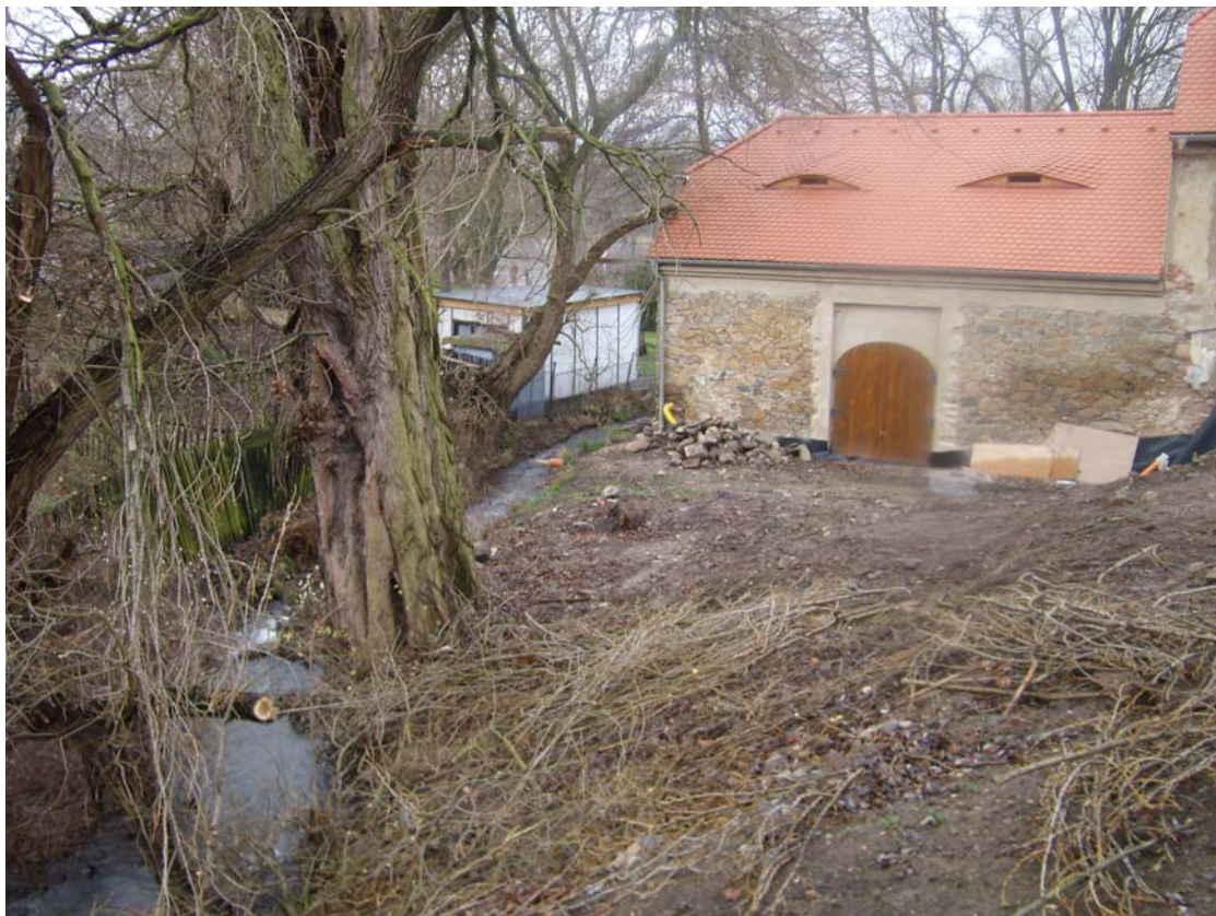
Foto č. 10: Rašovický potok – Pohled po proudu z pravého břehu na dvě ohrožené nemovitosti v ř. km 0,05.
