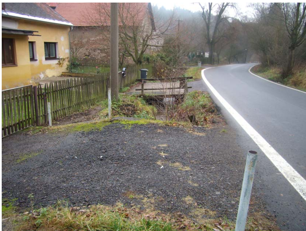
Foto č.7: Hradištský potok – Pohled po proudu na kritické profily a málo kapacitní přemostění.
