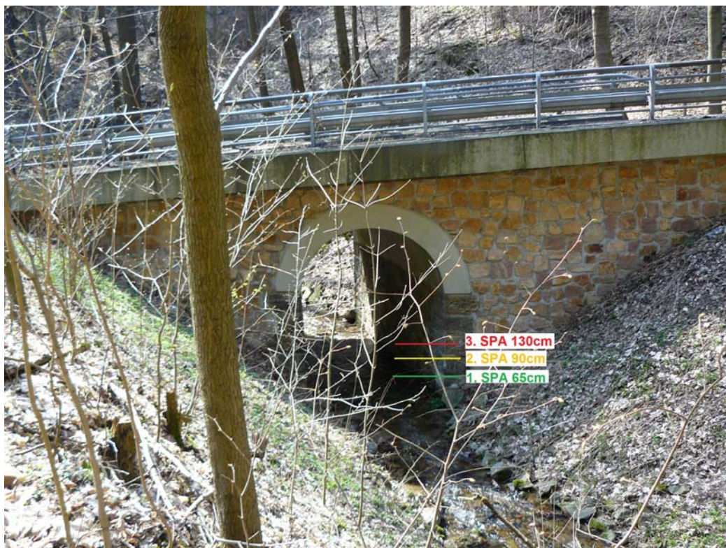
Foto č. 2: Klášterecský potok – Hlásný profil s automatickým vyhlásováním SPA v ř. km 2,83.
